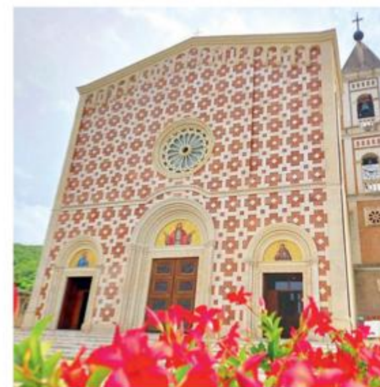
La facciata restaurata della basilica del Volto Santo a Manoppello liberata dalle impalcature dopo sette anni. Oggi alle 20 la cerimonia di benedizione con monsignor Domenico Angelo Scotti , vescovo della diocesi di Chieti-Vasto
